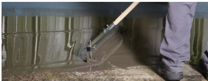
5 Pri obdelavi večjih površin za razporeditev materiala uporabite KÖSTER Gladilko za estrihe
