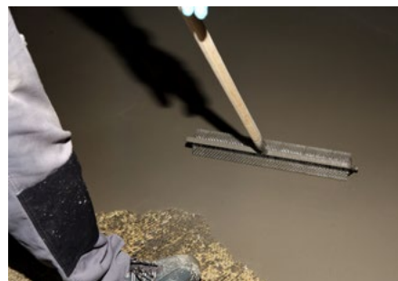
6 Za odzračevanje na koncu uporabite KÖSTER Ježasti valjček
