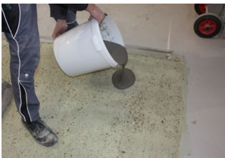
4 Zamešan material takoj po končanem mešanju razporedite po površini v zeleni debelini
