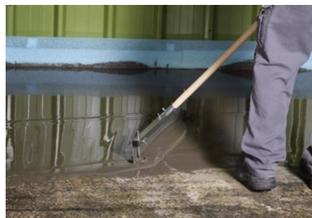
5 Na večjih površinah za razporeditev materiala uporabite KÖSTER Gladilko za estrihe
