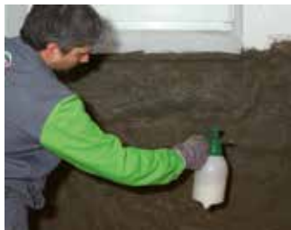
Osnovni premaz s KÖSTER Polysil TG 500
