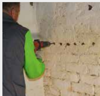
Horizontalno vrtanje v fugo
