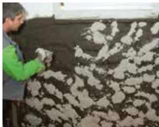
Nanos osnovnega obrizga KÖSTER Sanirni omet - osnovi obrizg
