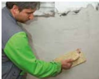
Zagljavanje površine ometa
