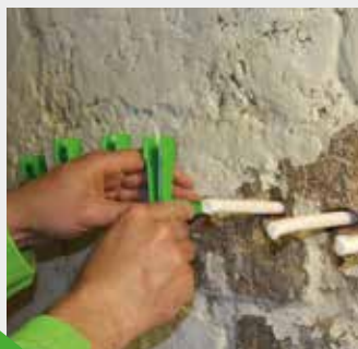
Vstavev KÖSTER Kapilarnih palčk in KÖSTER Kotnih nastavkov
